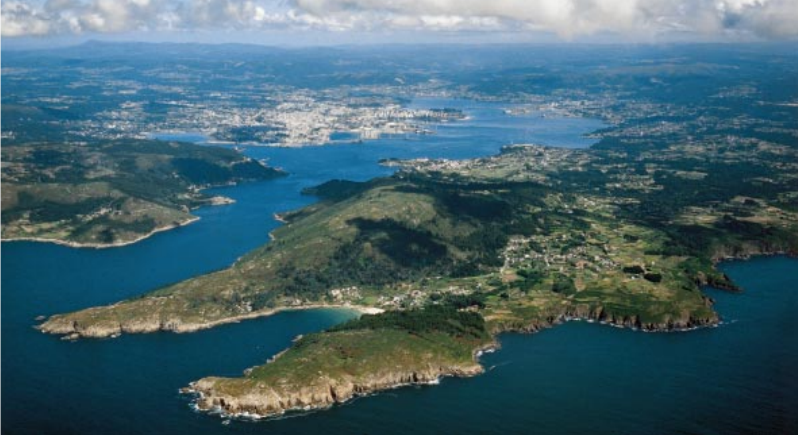
Vista aérea, Ría de Ferrol (A Coruña)
