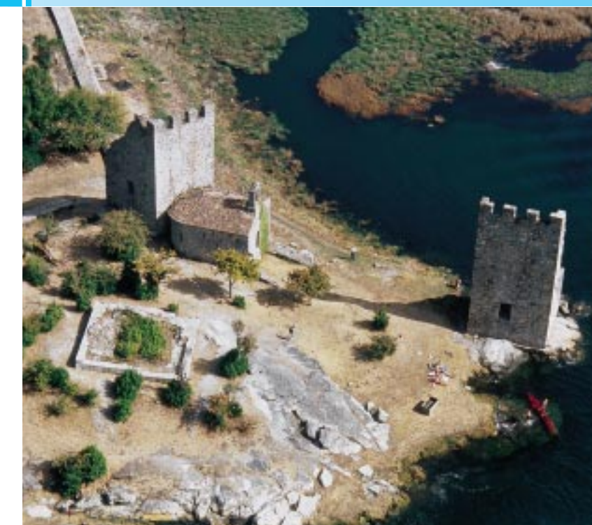
Torres de Oeste, Catoira (Pontevedra)
