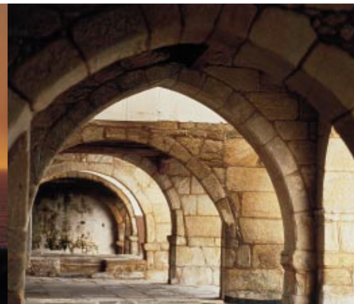
Muros (A Coruña)
